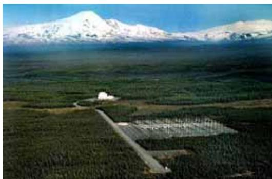
Комплекс АРФА на военной базе в Гаконе (Аляска, США)
